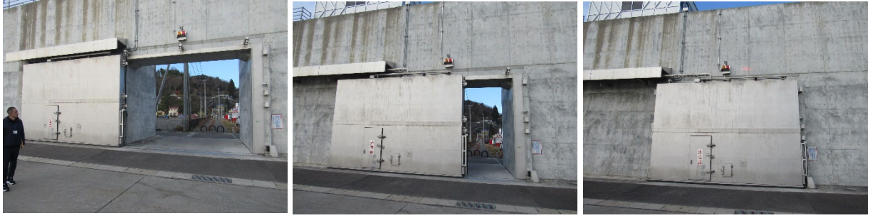
鍬ヶ崎陸閘 (試験稼働)
