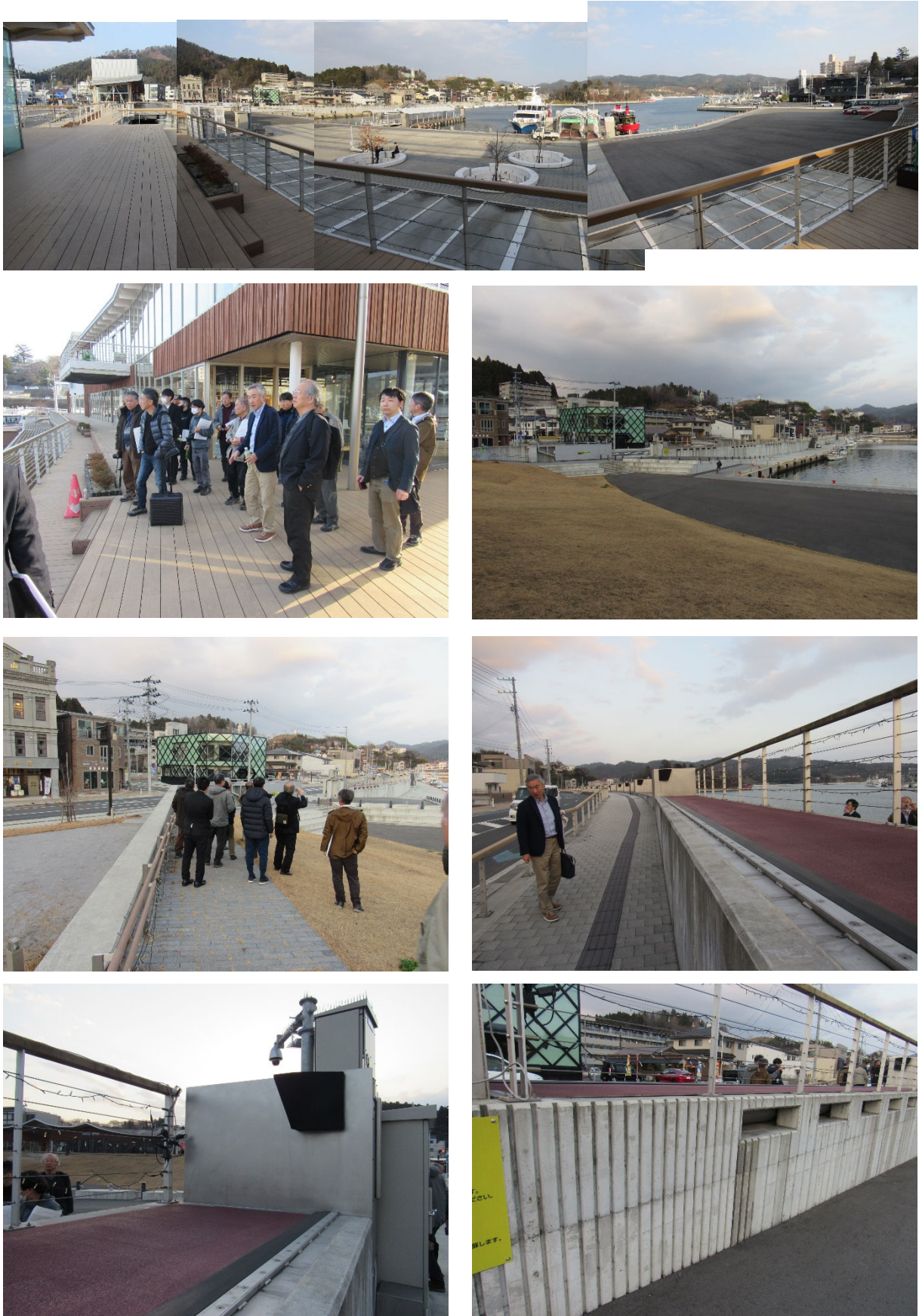
気仙沼市南町海岸における防潮堤（フラップゲート式陸閘）の整備状況
